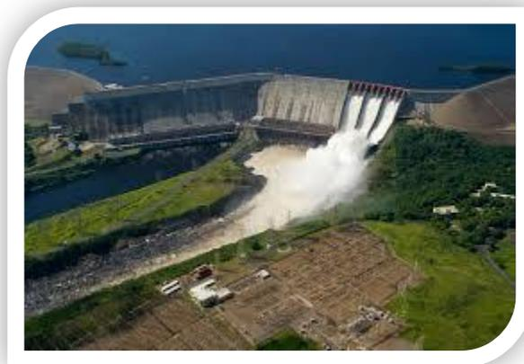
En una central hidroeléctrica, el agua que cae de una presa hace girar turbinas que impulsan generadores eléctricos. La electricidad se transporta a una estación de transmisión, donde un transformador convierte la corriente de baja tensión en una corriente de alta tensión. La electricidad se transporta por cables de alta tensión a las estaciones de distribución, donde se reduce la tensión mediante transformadores hasta niveles adecuados para los usuarios.
